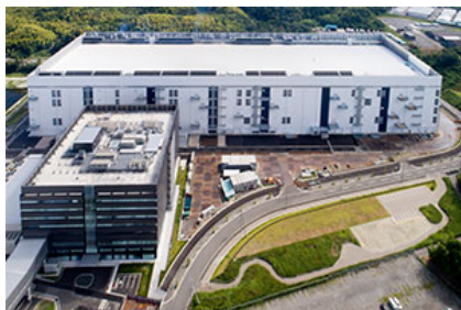
四日市工場 第6製造棟
