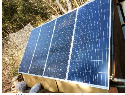
機材用の太陽電池パネル設置
