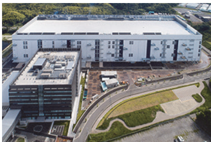
四日市工場 第6製造棟
