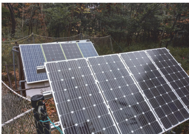
機材用の太陽光パネル設置
