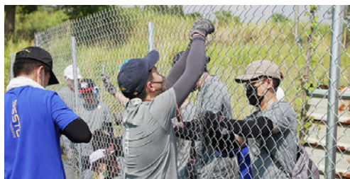
金網を設置する様子
