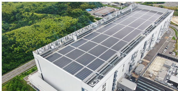
キオクシア株式会社四日市工場の太陽光発電システム（第6製造棟）
